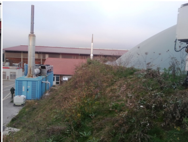
Foto 33: Det var ikke muligt at fotografere hele anlægget på ét foto. Her ses hvordan siderne af reaktoren er dannet af jord (Lagune)
