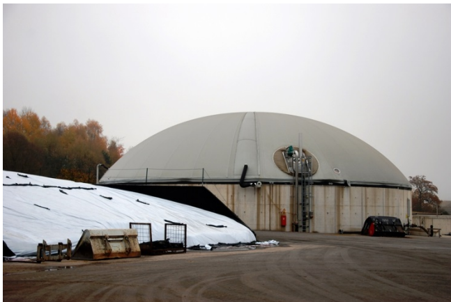
Foto 20: Den sekundære reaktor og lagertank. I forgrunden majsensilage til biogas.
