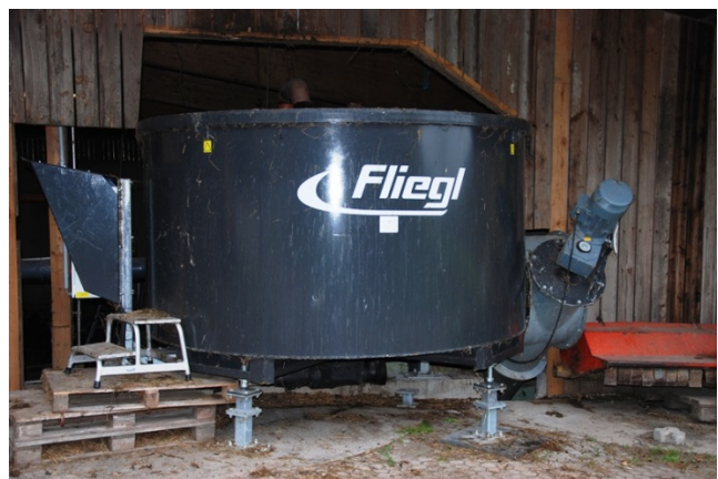
Foto 53: Indføddingen er af nyere dato og sneglen, der ses til højre, skubber biomassen nedad.
