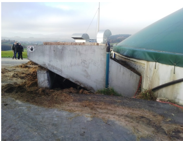
Foto 28: Indfødningsystemet er en slidske, der også fungerer som vandlås.
