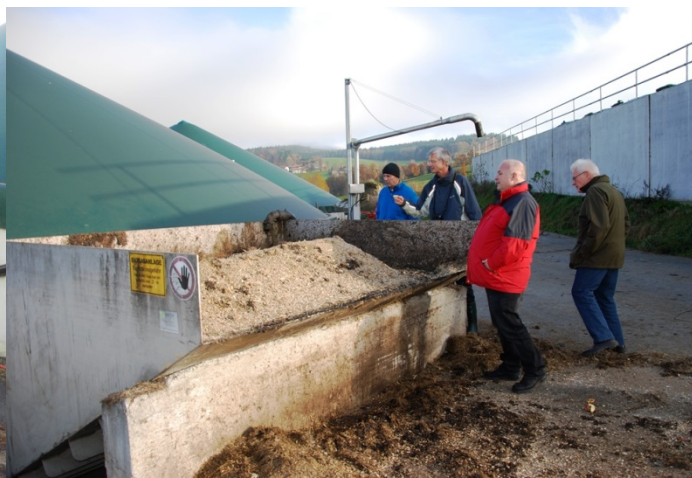
Foto 29: Der ligger materiale i slidsken så det fungerer som en "prop"
