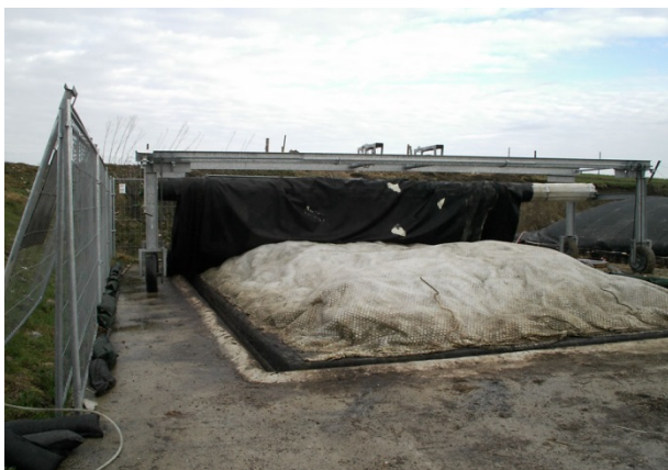
Foto 4: Applying an insulating mat.
