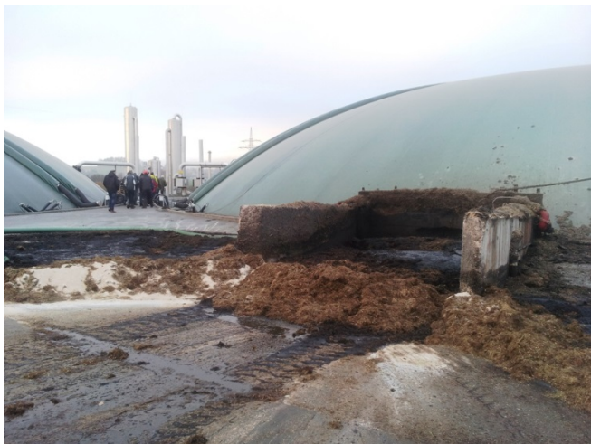
Foto 34: Indføding gennem en slidske (med teleskoplæsser).
