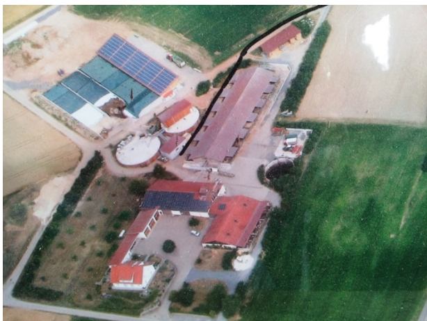
Foto 40: Luftfoto, der viser, at biogasanlægget er centralt placeret på ejendommen. Øverst til venstre ses ensilagesiloer og tørresiloer med solceller. Slagtesvinestalde med verandaer ses i midten / øverst i billedet.
