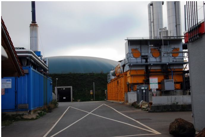
Foto 32: Til højre ses det spansk ejede gasopgraderingsanlæg. Til venstre ses containerhuset til en 1 MW gasmotor.
