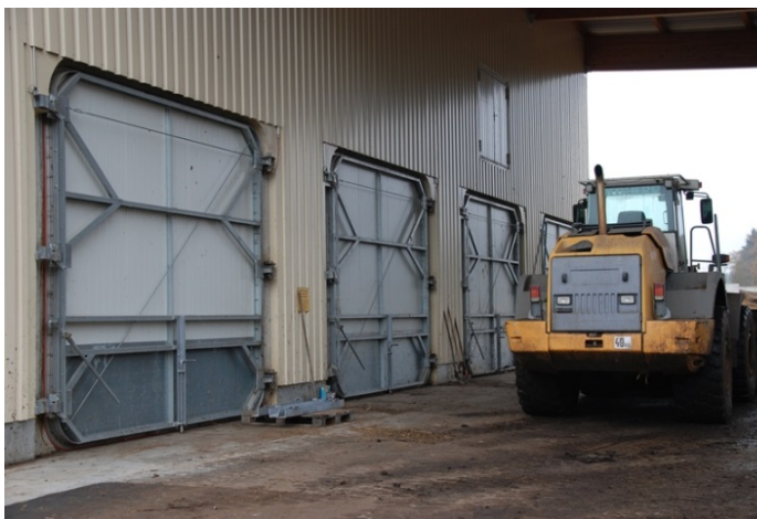
Foto 15: Garageanlæg til tørforgæring.
