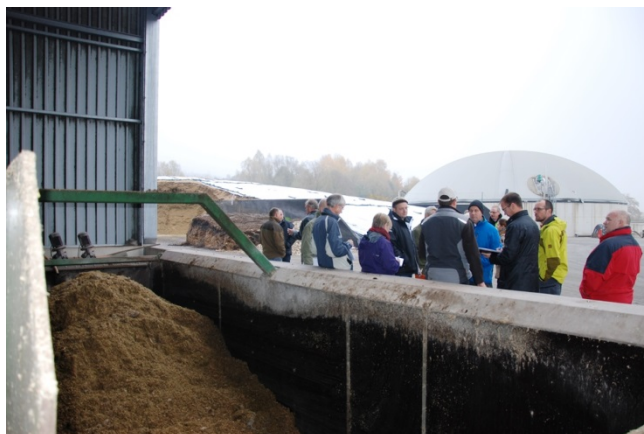
Foto 19: Biomassen føres ind med walking floor og løftes op i reaktoren med snegletransportør.
