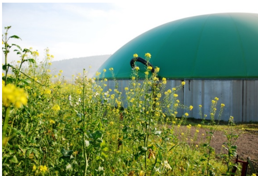
Foto 47: Lagertanken er også overdækket og kan bidrage med gasproduktion.
