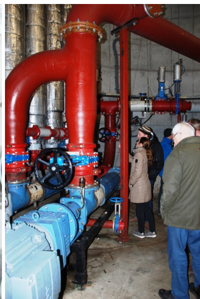
Foto 39: Store snekkepumper fører tynd væske op i tårnet, hvor en roterende vandkanon fordeler det over flydelaget.
