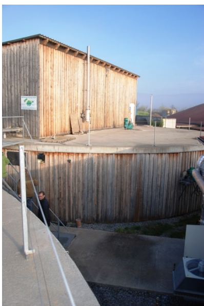
Foto 46: Her ses den sekundære reaktor, med et skur på toppen til opbevaring af biogas i en gassæk.
