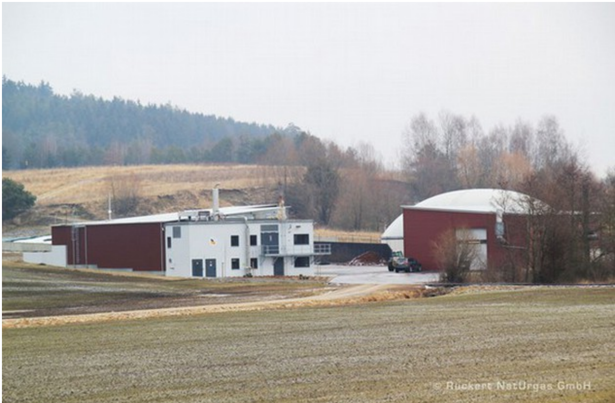
Foto 17: Biogasanlægget ses til venstre og anlæg til tørring af spildevandsslam ses til højre.
