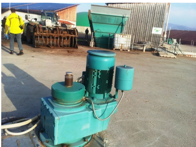
Foto 42: Konceptet i NQ-anlægget er et centralt langsomtgående padelværk, som er monteret i betonloftet og i gulvet i den primære reaktor.
