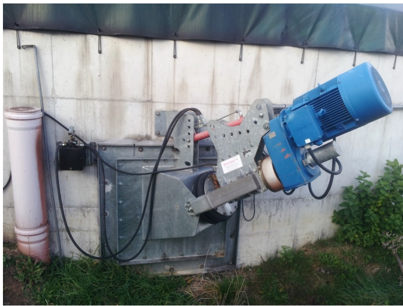
Foto 31: Omrøringen i den sekundære reaktor er med en langakslet propelomrører, der kan servieres og ændres i position udefra.
